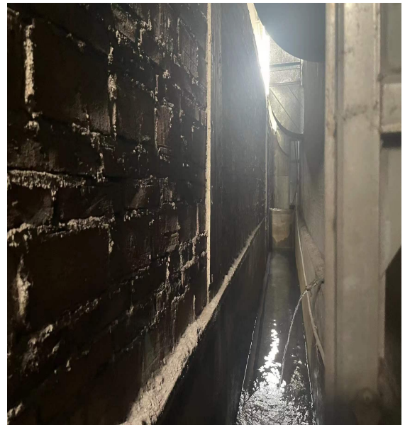
项目北侧 (商住楼)
