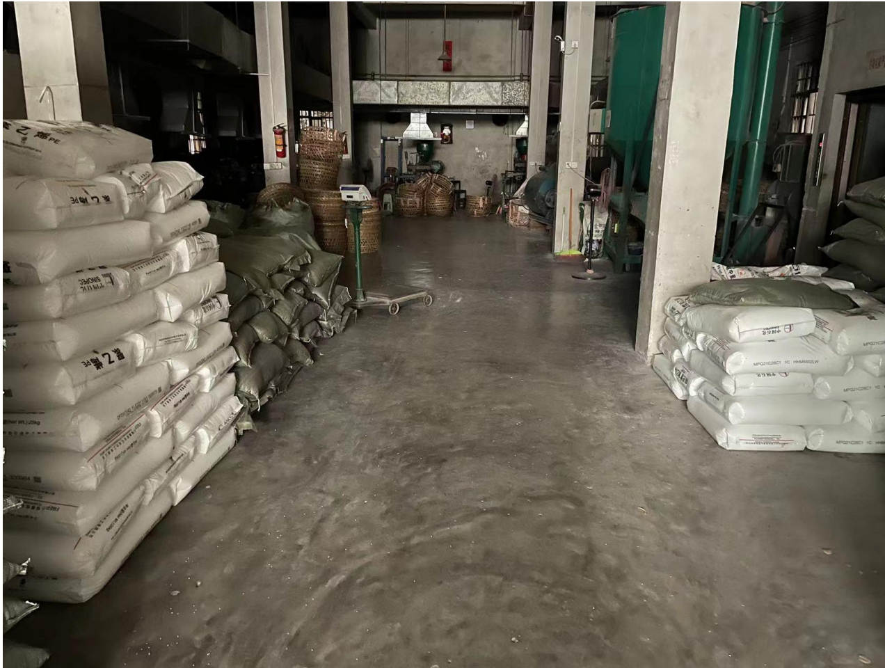
附图 7 项目现场硬底化图片
