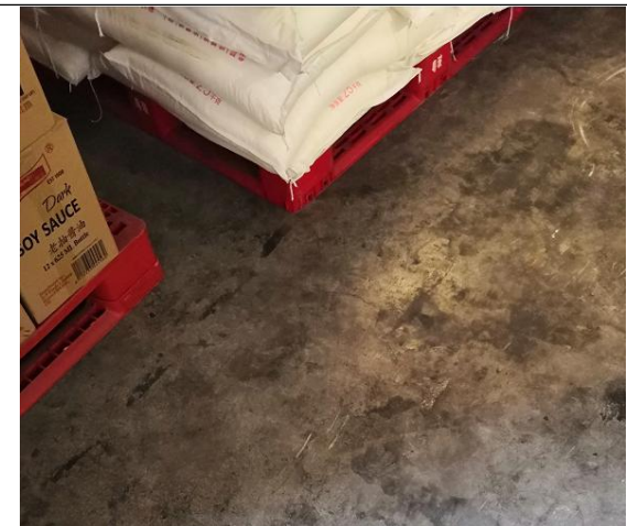
项目厂区硬底化现状
