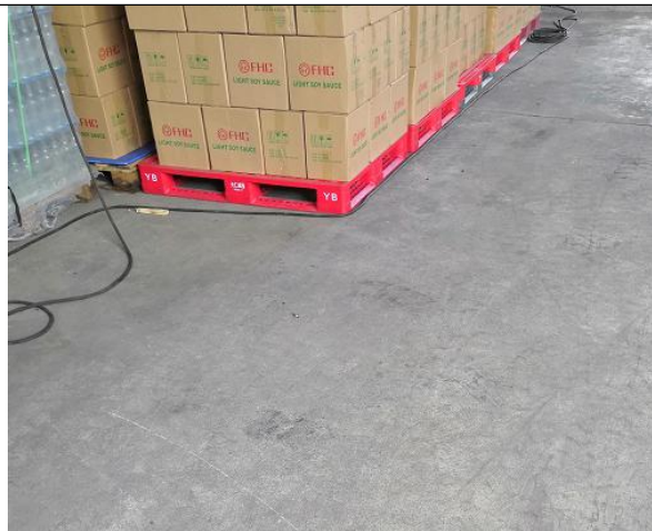
项目厂区硬底化现状
