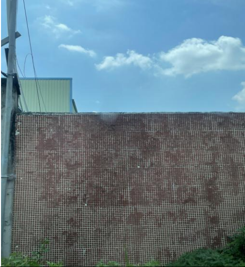
项目西侧（空地）
