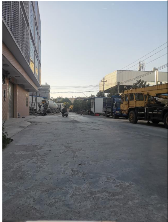
项目南侧（小路）
