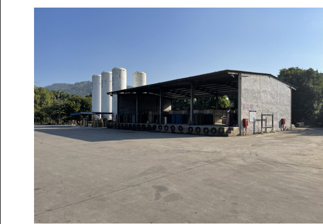
项目厂区内内部硬底化图片
