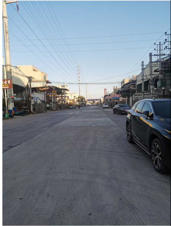
项目北侧（道路）
