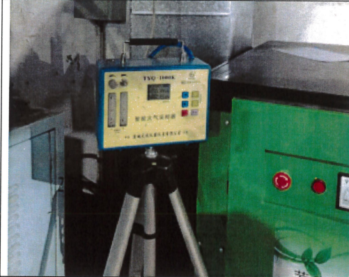
图 8.1 注塑工序废气处理前检测口 ○Q1
