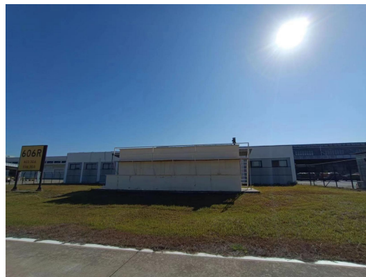
污水处理设施
