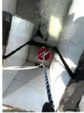
废水处理设施出口 B#
