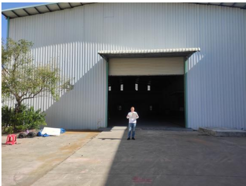
工程师现场照片远景
