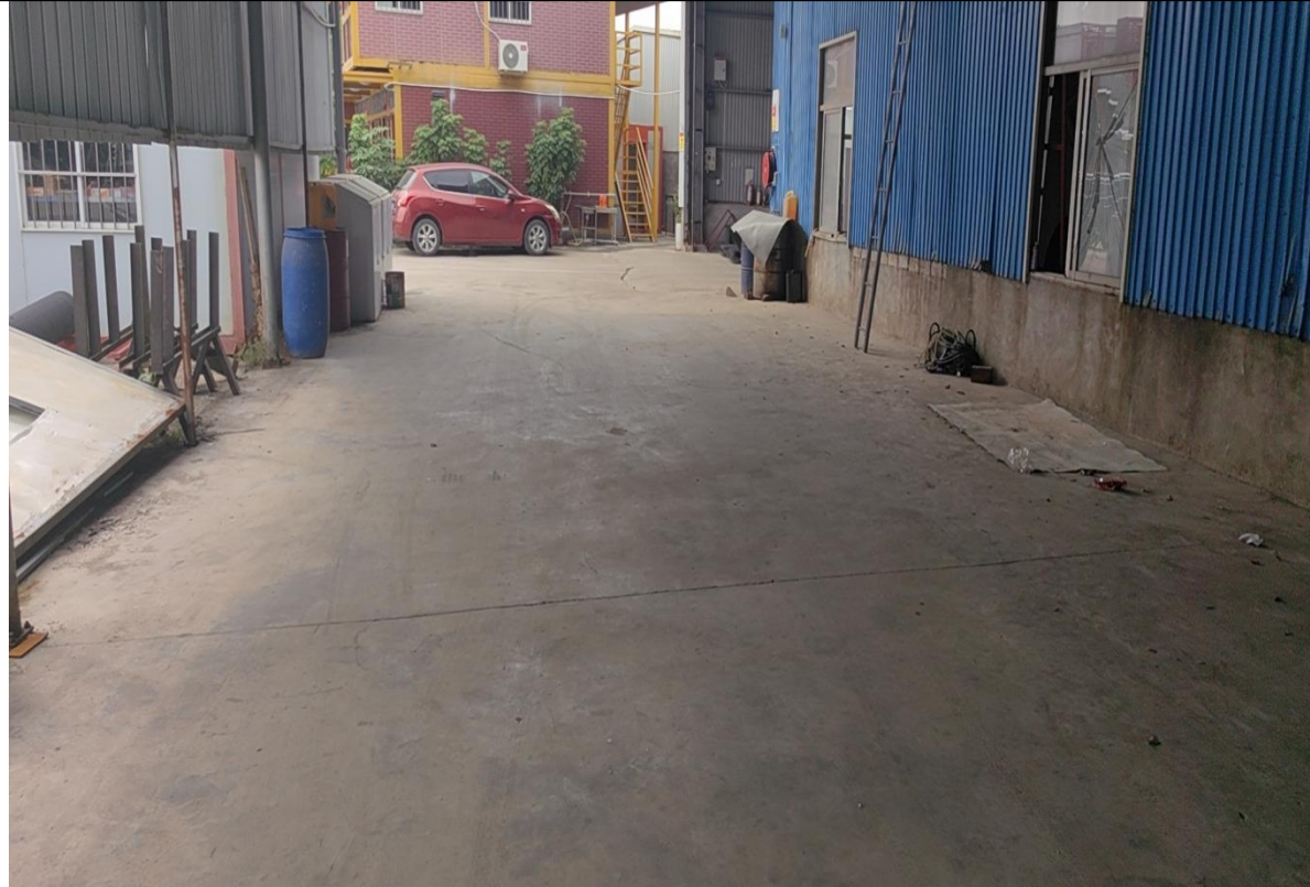
项目车间地面硬底化图
