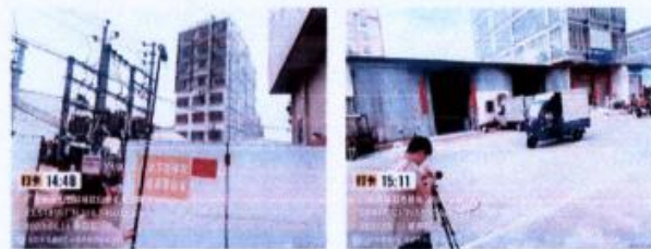
北面 40 米居民楼
