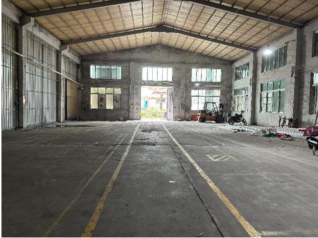
工业厂房内部现状相片
