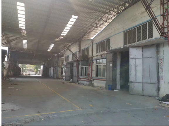
项目北面（空厂房）
