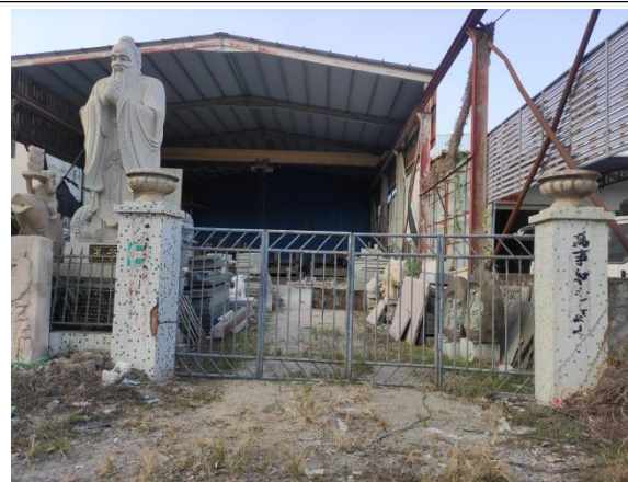
项目西面（厂房）
