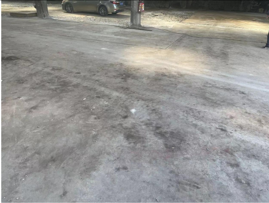
项目车间地面硬底化图
