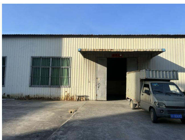
厂区门口现状
