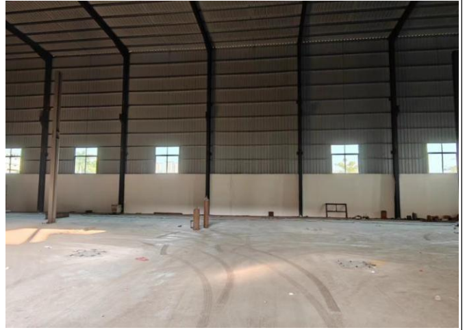
厂区注塑车间 2 现状图
