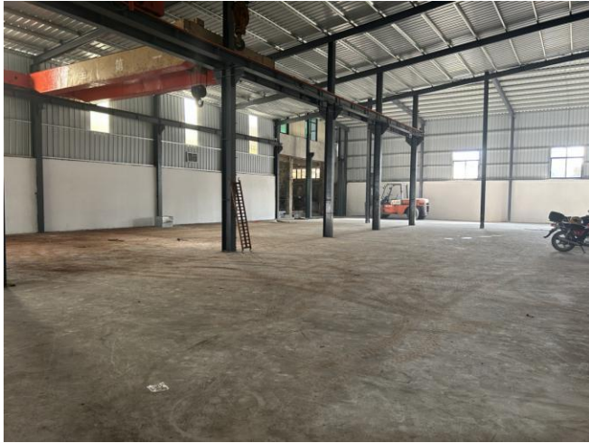
厂区注塑车间 1 现状图
