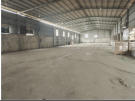
厂区内主要生产区
