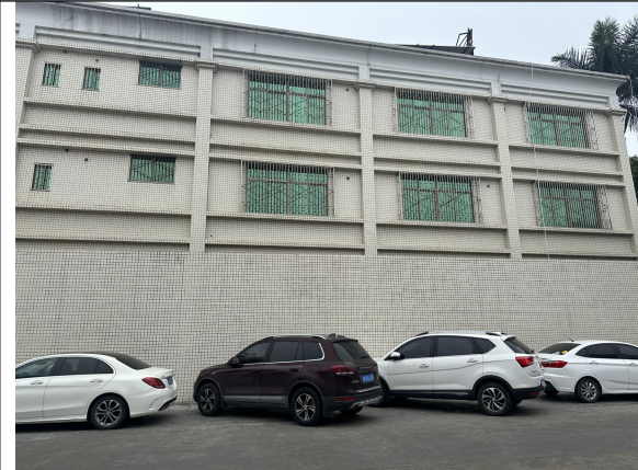
西面（潮顺人造板有限公司）
