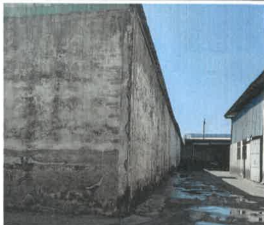
厂区南侧厂房
