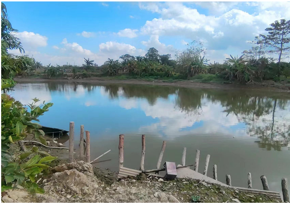
取水口河道现状图
