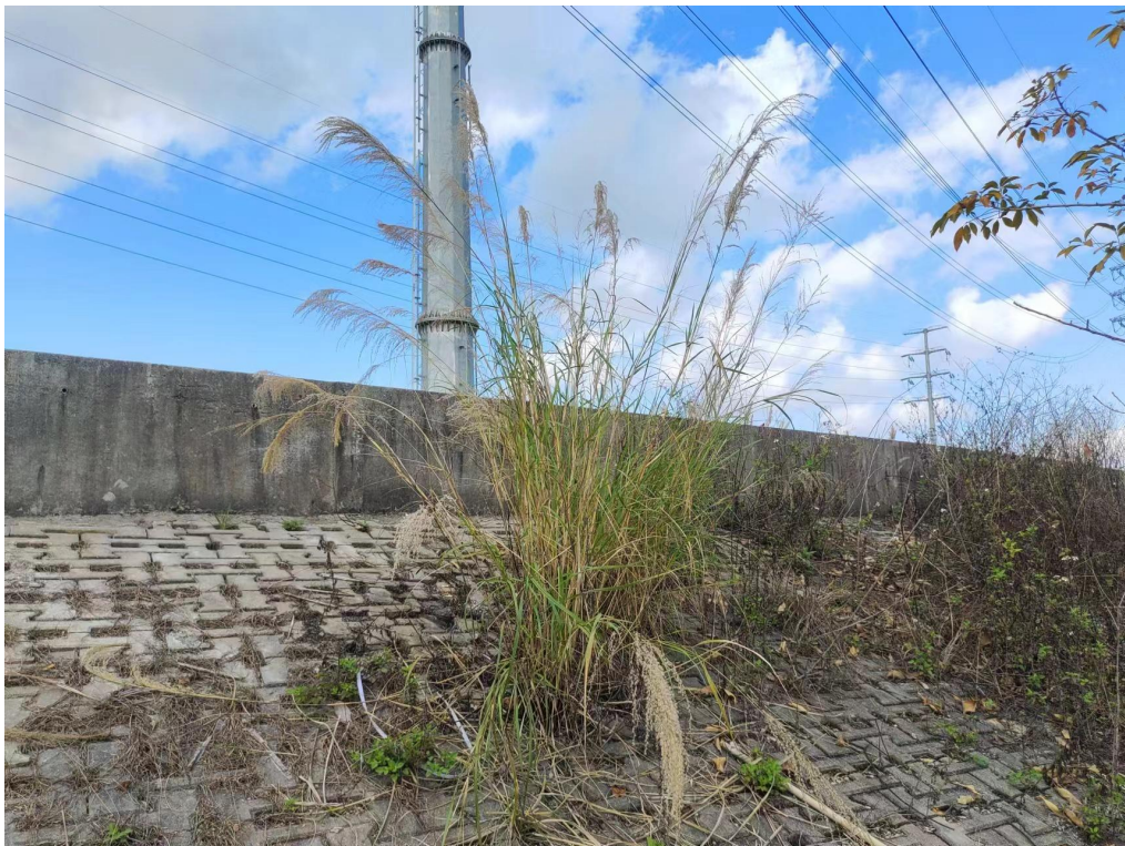
取水口堤段现状图
