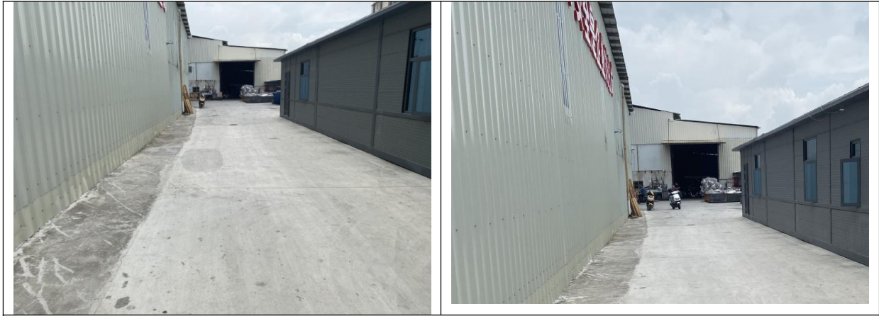
项目所在位置厂房内部现状相片
