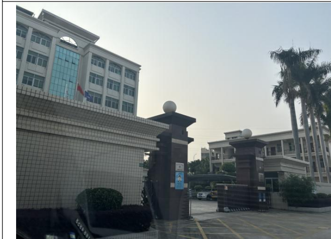
北侧-揭阳市榕城供电局榕东供电所
