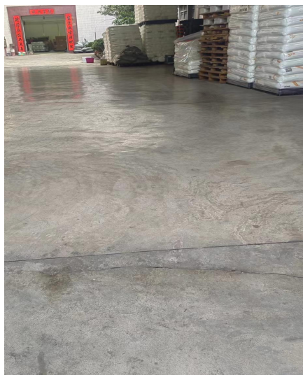
厂区硬底化情况
