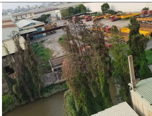
北面隔空地和梅溪为停车场
