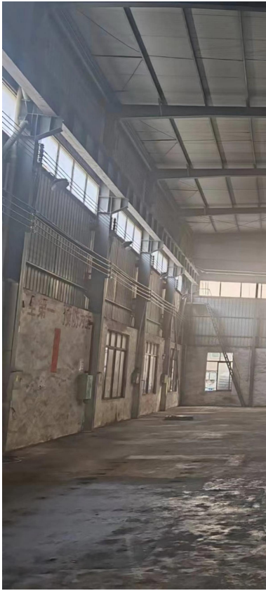
图 4-4 本扩建车间墙体结构照片
