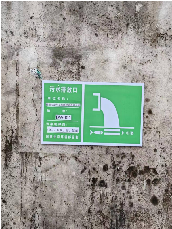
图 2-9 生活污水排放口
