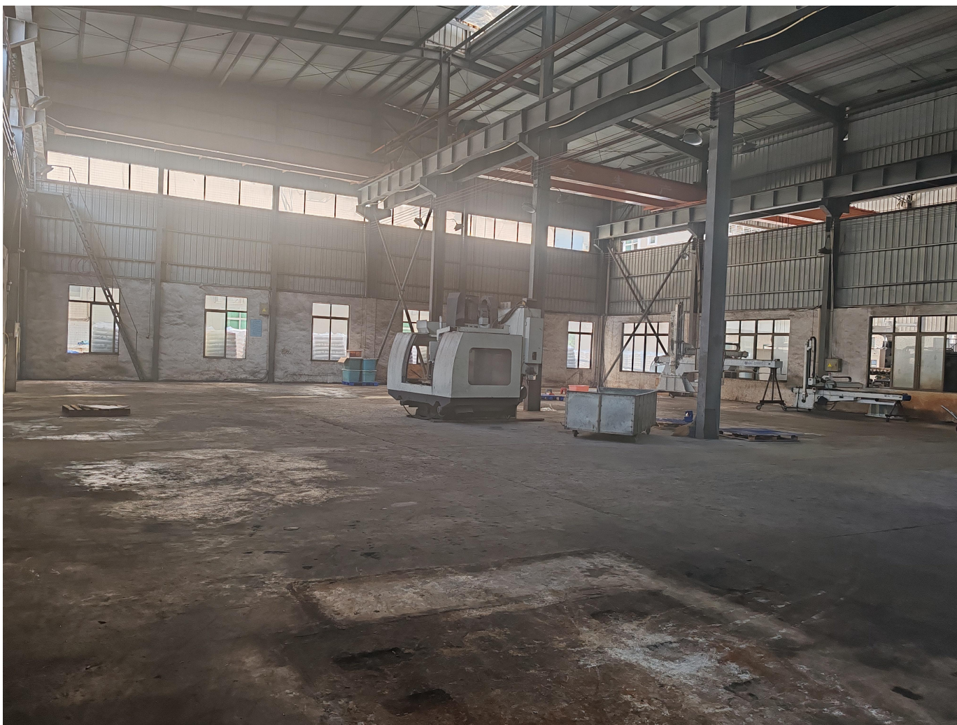
厂区硬底化现状
