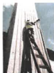
抛光车间1排气筒 (DA001)处理后
