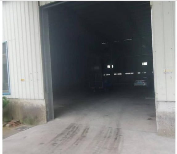
西北面为空厂房
