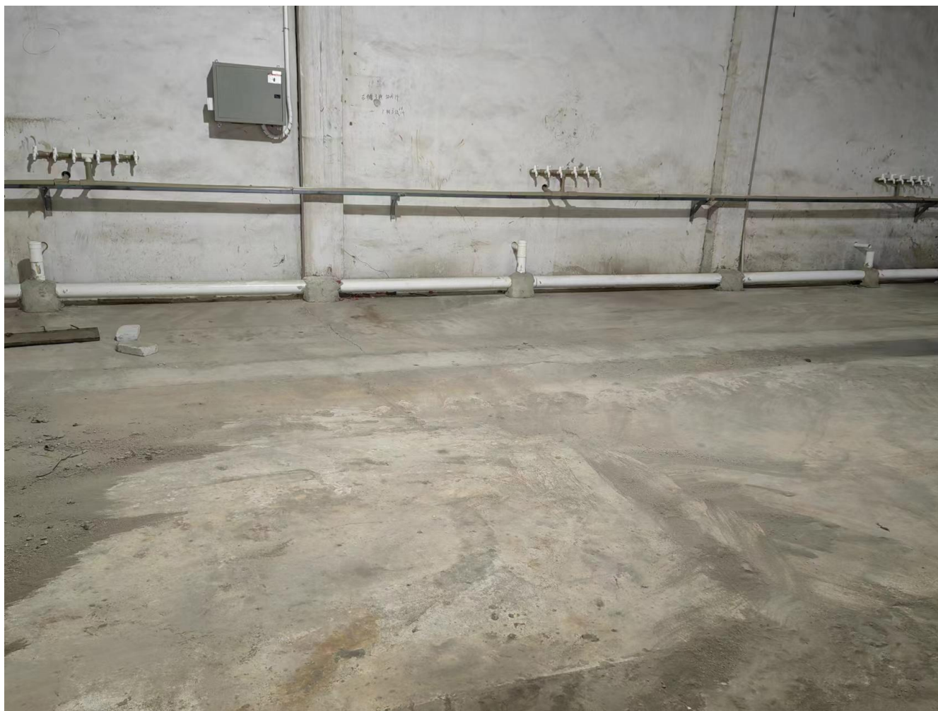
厂区内地面硬底化
