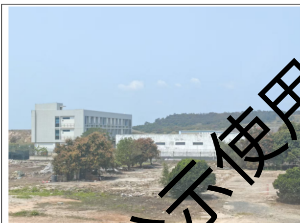
项目西北面 机场场各楼停车库及特车库
