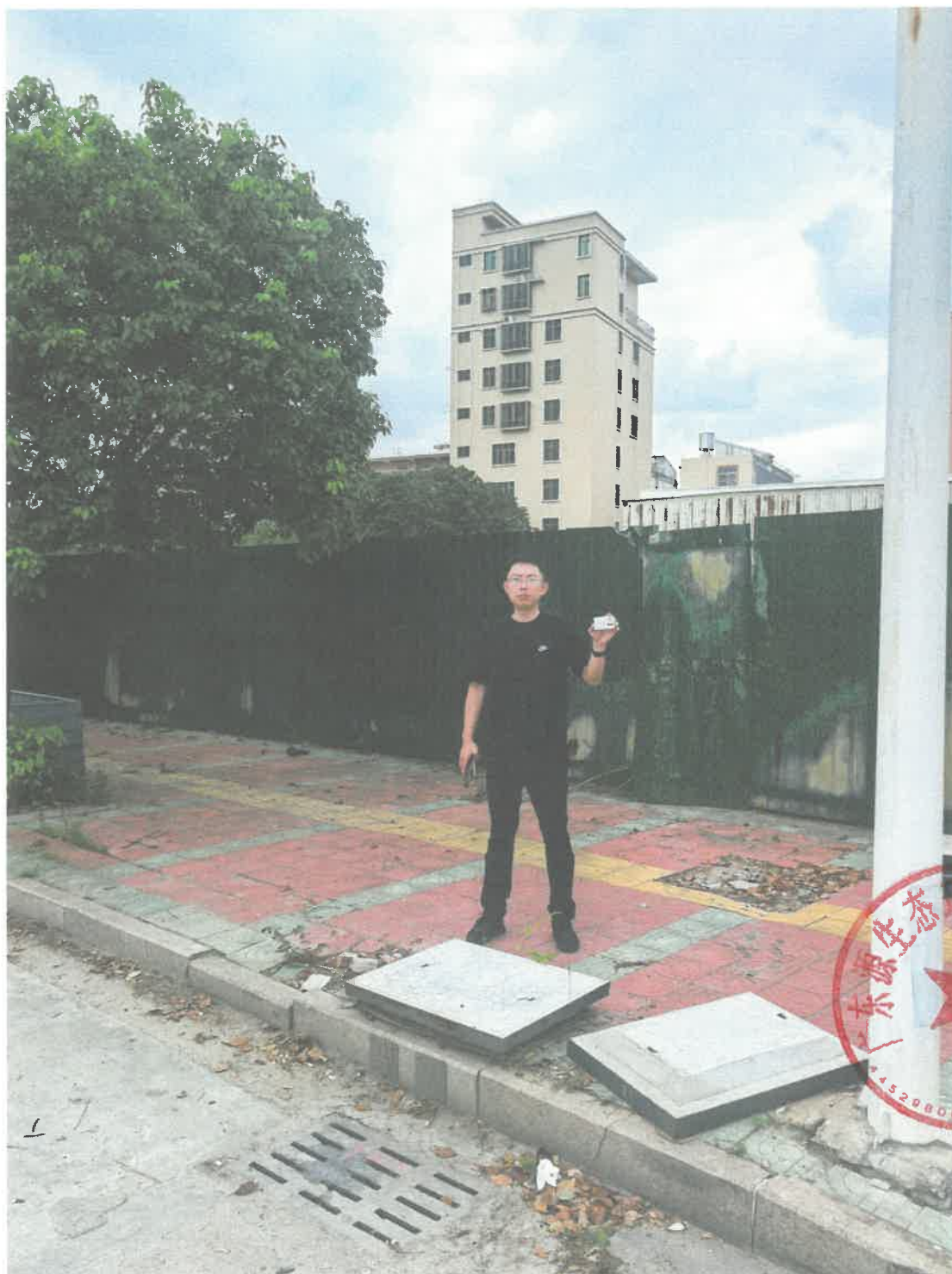
工程师现场踏勘照片
