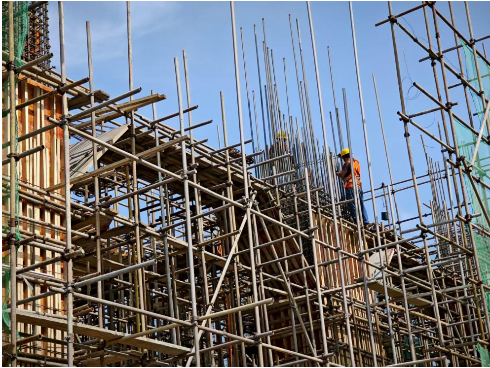
石灰窑体框架施工现场照片 2
