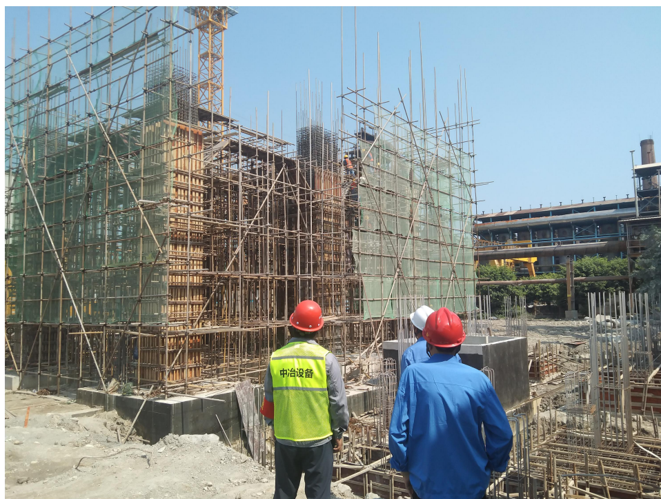
石灰窑体框架施工现场照片 1
