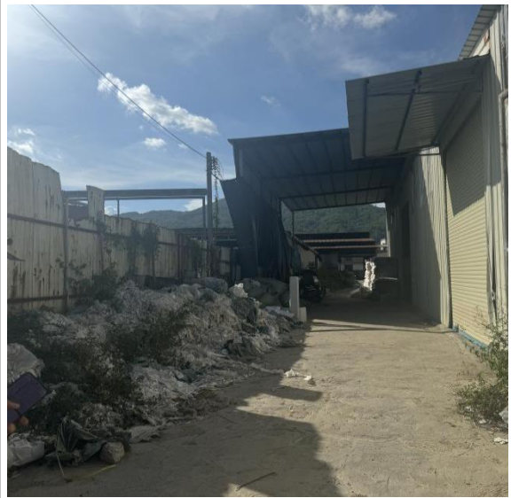
项目南侧（厂房）
