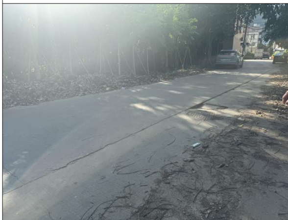
项目西侧（道路）
