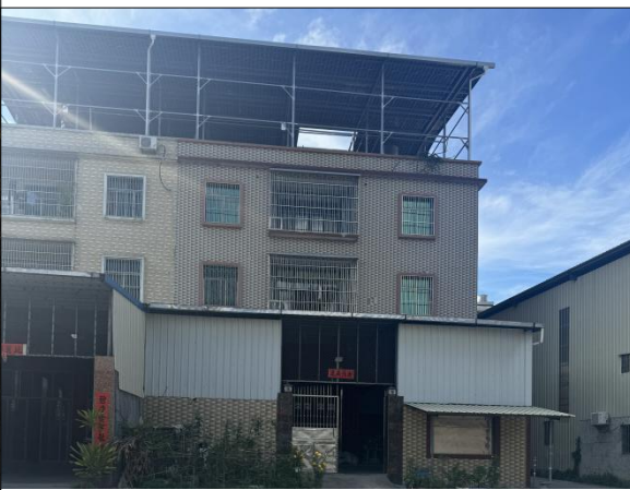
项目北侧（道路、商住混合楼）
