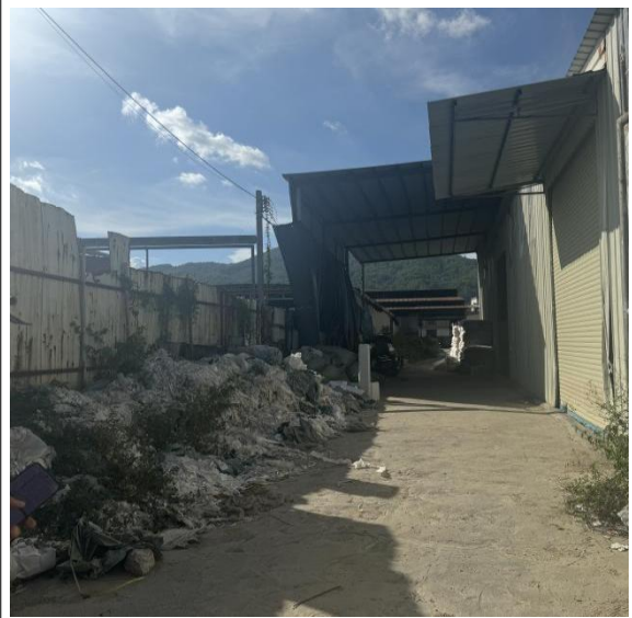
项目南侧（厂房）
