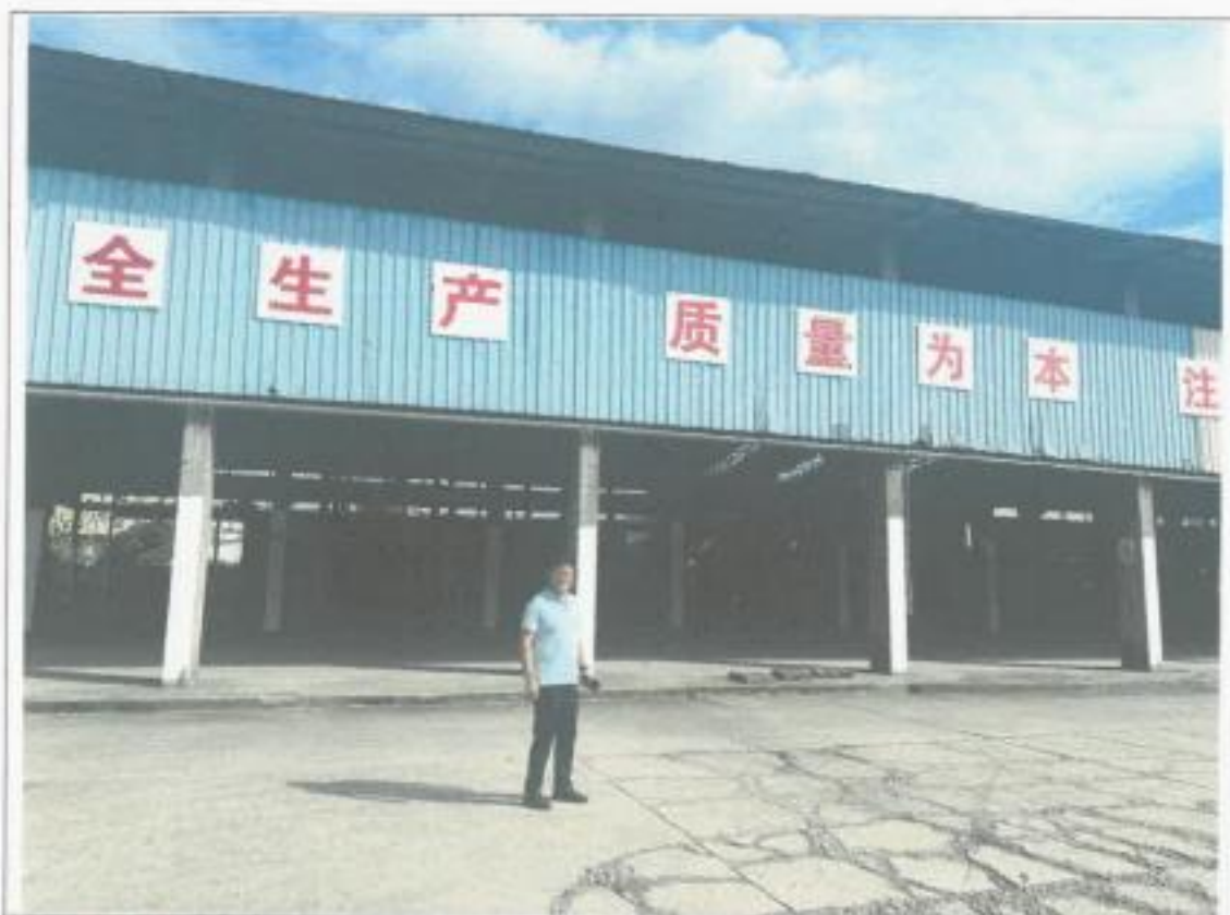
工程师现场照片：
