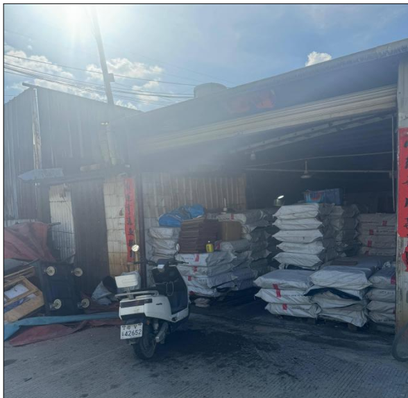
项目东侧（商住混合楼）
