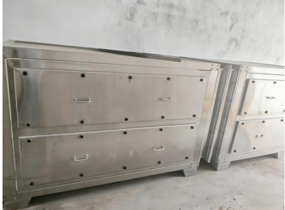
活性炭箱及吸附层（处理造粒工序产生的非甲烷总烃、恶臭气体）
