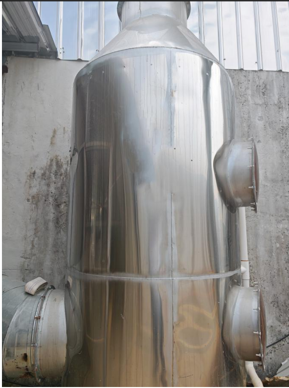
水喷淋（处理造粒工序产生的颗粒物）
