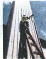
抛光车间1排气筒 (DA001) 处理后
