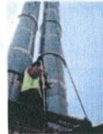
抛光车间2排气筒 (DA002) 处理后
