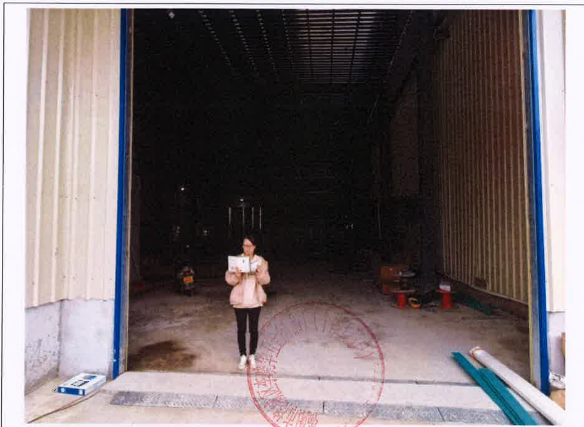
现场勘查照片：
