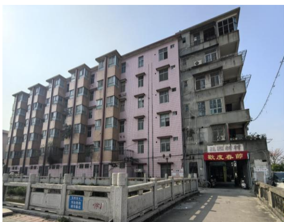
图 6-3 五类风貌建筑
