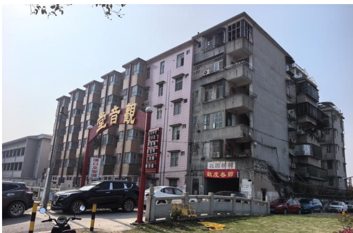
图 4-30 风貌不协调的建筑
