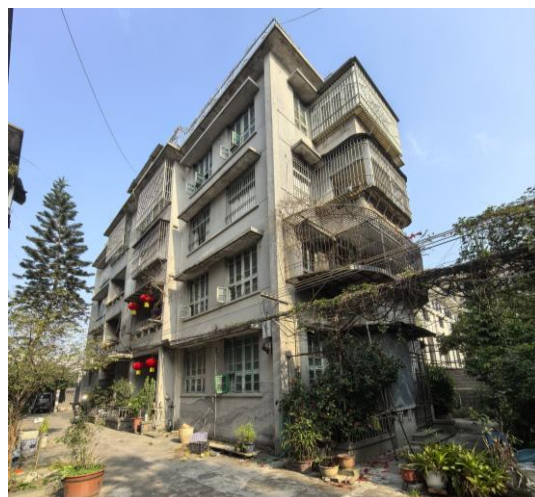
图 6-2 四类风貌建筑
