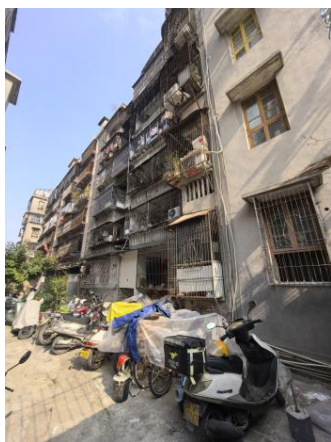
图 4-32 风貌不协调的建筑
