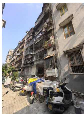
图 6-4 五类风貌建筑
