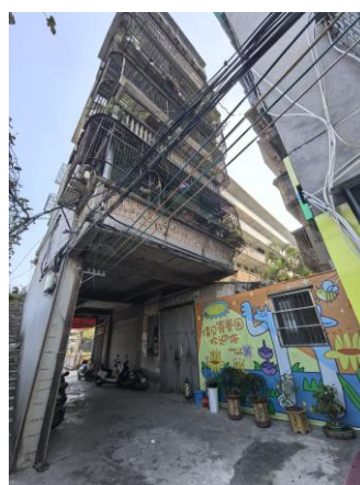
图 4-33 风貌不协调的建筑
