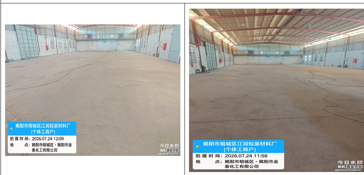
厂房内部现状相片
