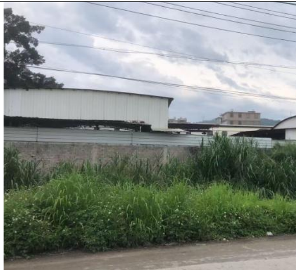
南面隔道路和小河为工厂厂房
