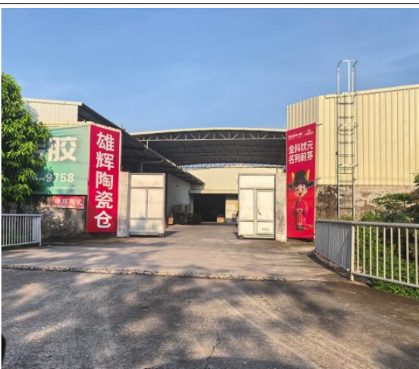
西面为厂房、仓库
