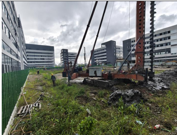
东北面为在建厂房
