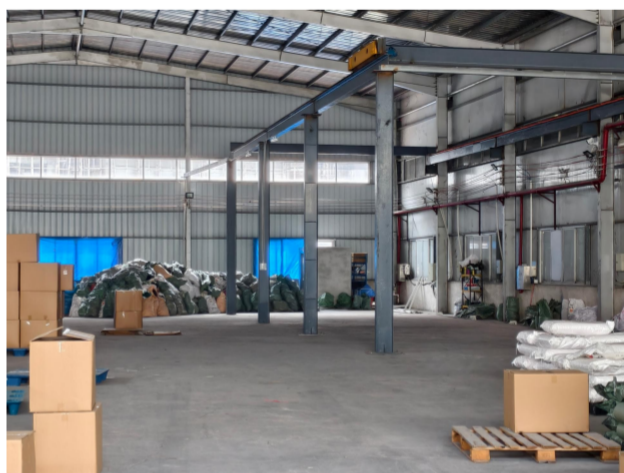
项目厂房内部现场
